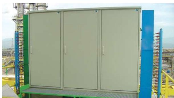
Armoires polyester anti-corrosion, étanches et/ou ventilées, finition extérieure Gel coat anti-UV, anti-graffiti. Garantie du revêtement extérieur : 10 ans. Les grandes dimensions vont de 1900 x 665 x 400 à 1900 x 6390 x 1000 mm.
