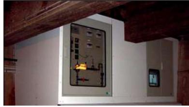
Ensemble d'armoires dédiées à l'analyse et le traitement de l'eau à Paris. Pour cette application, la tenue des matières composites (polyester armé fibres de verre) aux agents agressifs et corrosifs doit être irréprochable (égouts de Paris). L'utilisation de résine et GEL COAT adaptés permettent d'obtenir un ensemble très résistant. Un ensemble sur mesure a été ainsi réalisé et adapté aux dimensions et emplacement souhaités.
