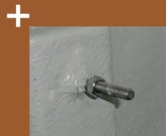
**8 goujons M6** en fond d'armoire permettant la fixation de votre châssis.
