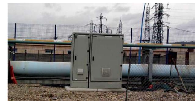
Armoires polyester anti-corrosion, étanches et/ou ventilées, finition extérieure Gel coat anti-UV, anti-graffiti. Garantie du revêtement extérieur : 10 ans. Grandes dimensions de 1900 x 665 x 400 à 1900 x 6390 x 800 mm . La résistance aux impacts mécaniques est très élevée IK 10 et permet ainsi l'installation de ces armoires dans de nombreux sites industriels.
