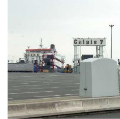
EUROPOLY, en collaboration avec son client et la commune de Calais, a conçu, réalisé les outillages d'un capot permettant d'isoler, des infiltrations d'eau, des coffrets prises escamotables.
