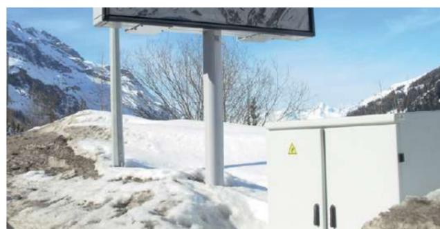
Armoires polyester anti-corrosion, étanches et/ou ventilées, finition extérieure gel coat anti-UV, Cette gamme d'armoire permet de cloisonner des compartiments, d'assembler des modules, ainsi nous pouvons réaliser une armoire avec un compartiment 19" comportant des éléments actifs, puis un autre compartiment comportant de la fibre optique.
