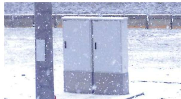
Armoires polyester anti-corrosion, étanches et/ou ventilées, finition SMC. L'intérêt majeur de ces armoires est leur modularité. En associant des composants standards, nous pouvons réaliser des armoires de dimensions 500 x 500 x 300 à 1250 x 2000 x 500 mm. Ces armoires sont parfaitement étudiées pour les applications électriques routières, autoroutières mais également pour l'installation de matériel de télécommunication, vidéosurveillance...
