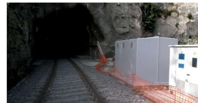
Cabines polyester anti-corrosion, finition gel coat anti-UV. Ces cabines peuvent être livrées avec ou sans isolation thermique. Les dimensions sont de hauteur de 2400 mm, largeur : 2000 mm et longueur 1730 à 4230 mm. En standard, ces cabines sont livrées sans bas, permettant ainsi de capoter directement un équipement et de se fixer sur un massif béton. Elles sont proposées, en option, avec socle inox, galva ou polyester.
